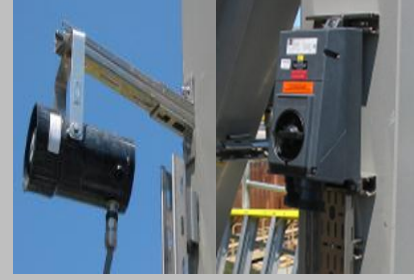
Junction box montajı (Kaynaksız çözüm)
