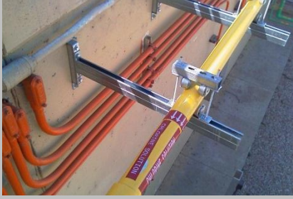
Boru support montajı (Kaynaksız çözüm)
