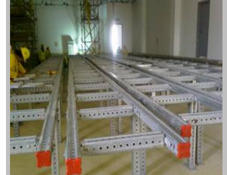
Entegre yükseltilmiş döşeme (Kaynaksız çözüm)
