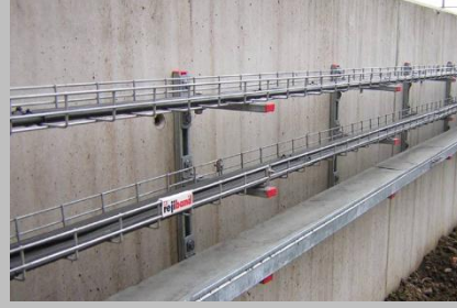
Kablo tavası & HVAC (Kaynaksız çözüm)
