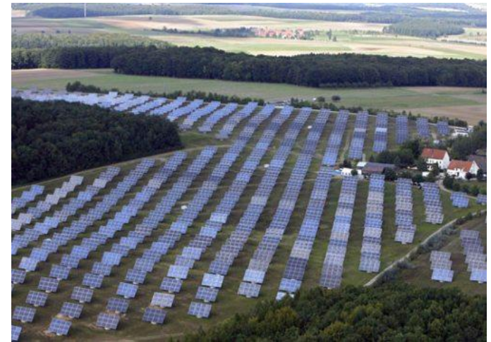
Gut Erlasee Solar Park Almanya 12 MW
