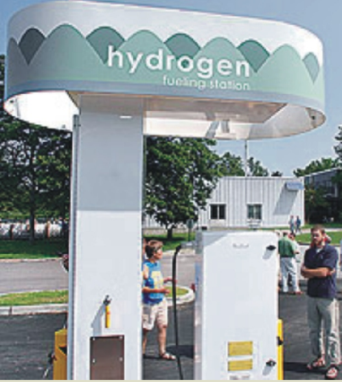
TEMİZ YAKIT: Burlington'daki bu dolum istasyonu, yakıt hücreli arabaları çalıştırmak için suyu hidrojene dönüştürmede elektrik kullanıyor. Bu, Enerji Departmanı'nın daha soğuk iklimlerde alternatif yakıtların test edildiği programın bir parçası.
