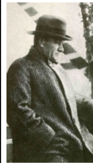
Soğuk bir kış sabahında Ankara Çubuk Barajı'nda bir incelemede, [1]
