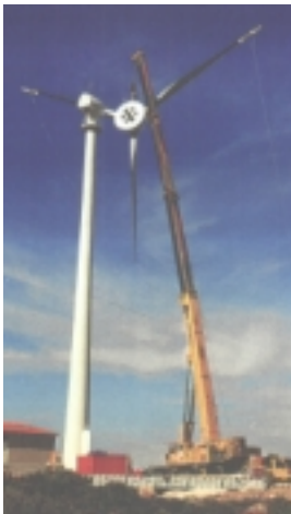
Çeşme-Alaçatı rüzgar enerjisi santrali, rüzgar türbini montajı, 1998.
