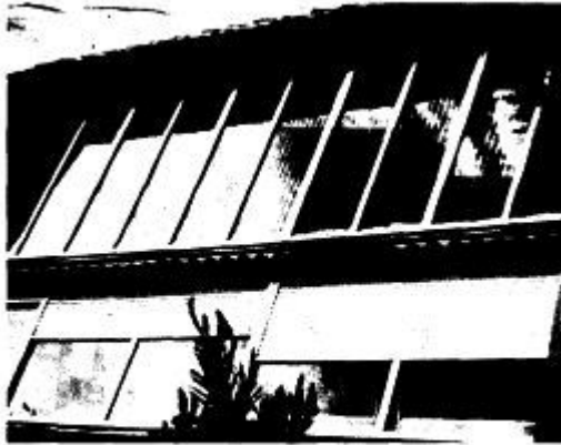
Şekil 3. Sıcak Su Temini İçin Kullanılan Düz Toplayıcıların Değişik Bir Uygulaması
