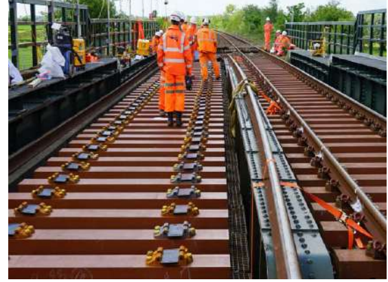
Şekil 5. Günümüzde kritik hat kesimlerinde kullanımı artan kompozit traverslere dair bir örnek (FFU-tipi) [16]
