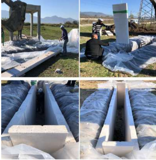
Şekil 7. Gaz beton cidarlı açık hendek tipi dalga bariyerinin inşaatı
