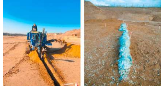
Şekil 2. Kum-çakıl karışımı test sahasında geofoam dolgulu hendek uygulaması
