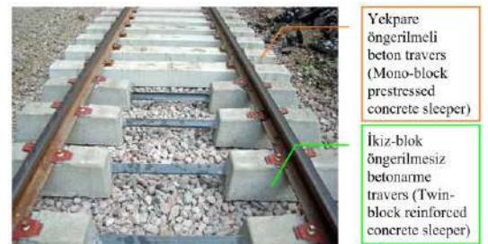
Şekil 2. Balastlı demiryolu hatlarında en yaygın kullanılan alanına sahip beton travers çeşitleri [7]
