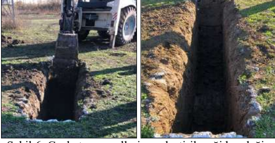
Şekil 6. Gazbeton panellerin yerleştirileceği hendek açılması
