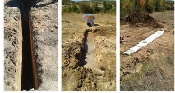
Şekil 1. Titreşim yalıtımı için dalga bariyer modelleri: açık hendek, su dolu hendek ve geofoam dolu hendek
