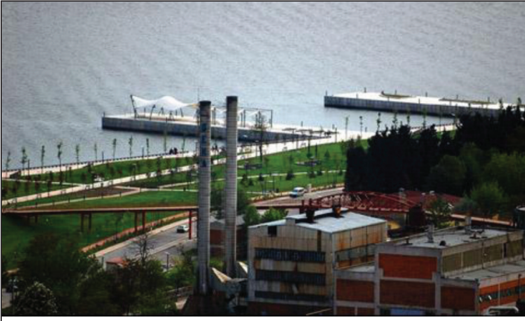
Şekil 1. SEKA kağıt fabrikası alanından bir görünüş
