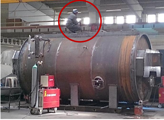
Şekil 8. a) Önlem Alınmadan Yüksekte Yapılan Kaynak İş
