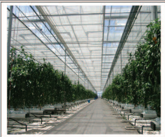
Şekil 7. Isıtma borularının sera zeminine yerleştirilmesi
