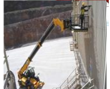
Şekil 2.37- Telehandler ile yüksekte çalışma
