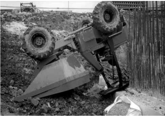
Şekil 2.18- Devrilmiş damper- HSE
