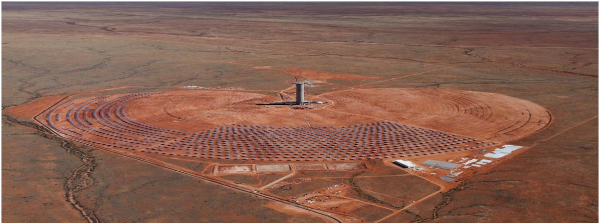
Şekil 8. TuNOOR kule tipi CSP santrallerinden biri.
