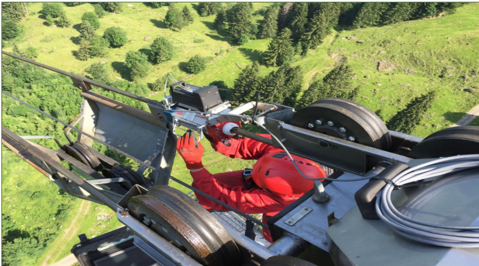
Şekil 3. Halatlı Taşıma Sistemlerinde Tahribatsız Muayene Uygulaması
