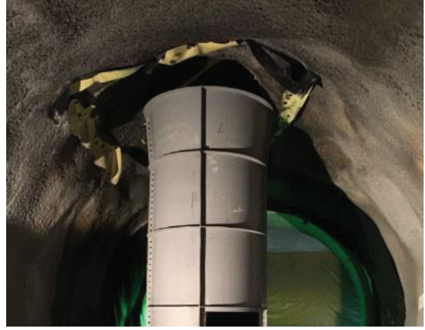
Karayolu Tüneli Havalandırma Şaftları Kaplamalarında Kompozit CTP Boru Kullanımı
