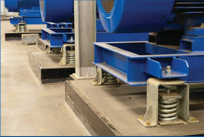
Şekil 3. Makinalarda Titreşim Yalıtıcı Kullanımına Örnek (Kaynak: Embelton Engineering)
