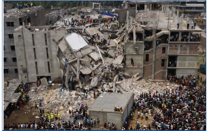
Şekil 4. Bangladeş, Rana Plaza. Yıkılma Nedeni: Jeneratörlerin Neden Olduğu Bina Titreşimleri
