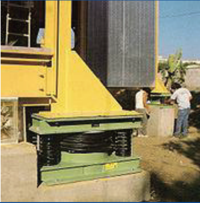
Şekil 1. Santa Monica, California'da Üç Katlı Bir Evin Depreme Karşı Yalıtımında Kullanılan Yay-Sönüm Sistemi (Creative Commons)
