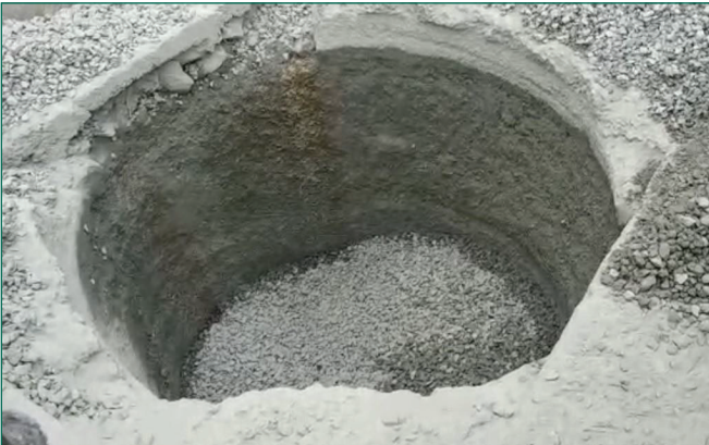
Fotoğraf 2. Şaft Kuyusunun Kırmataş Malzeme ile Doldurulması
