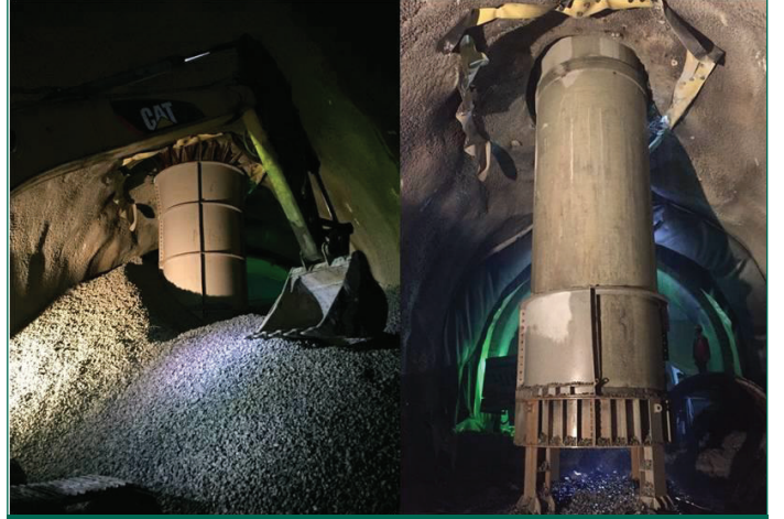
Fotoğraf 7. Kıırma Taş Malzemenin Sağılması ve Borunun Çelik Sephaya Oturması
