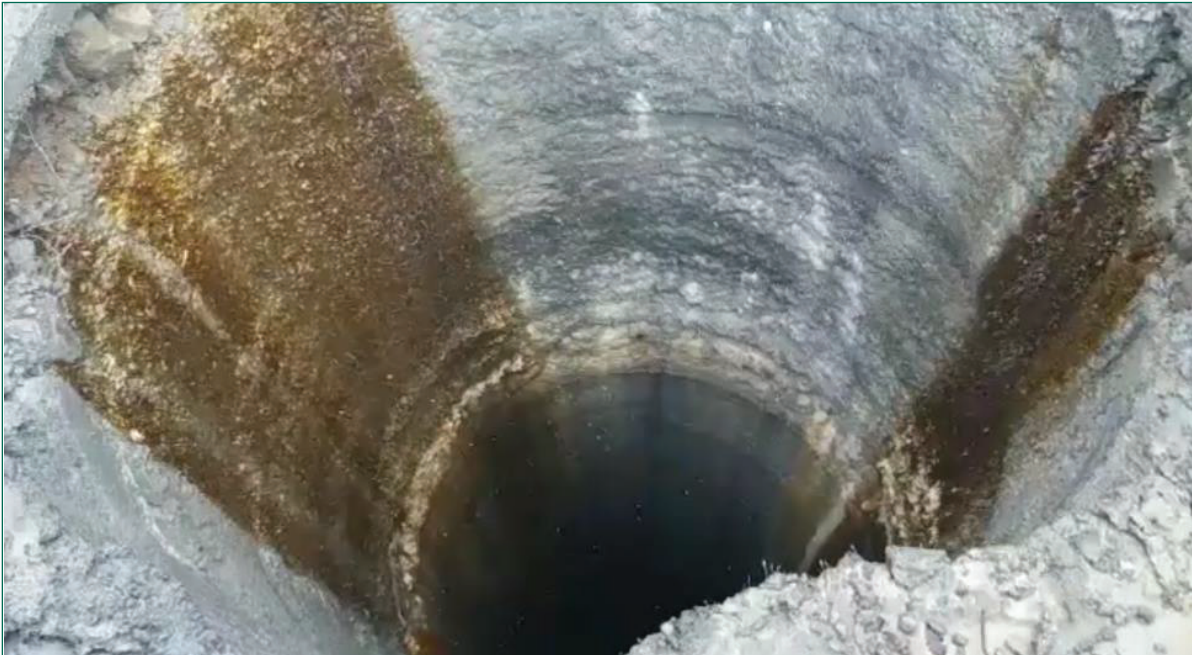
Fotoğraf 1. RBM ile Açılmış Havalandırma Şaftının Kaplama Öncesi Üstten Görüntüsü
