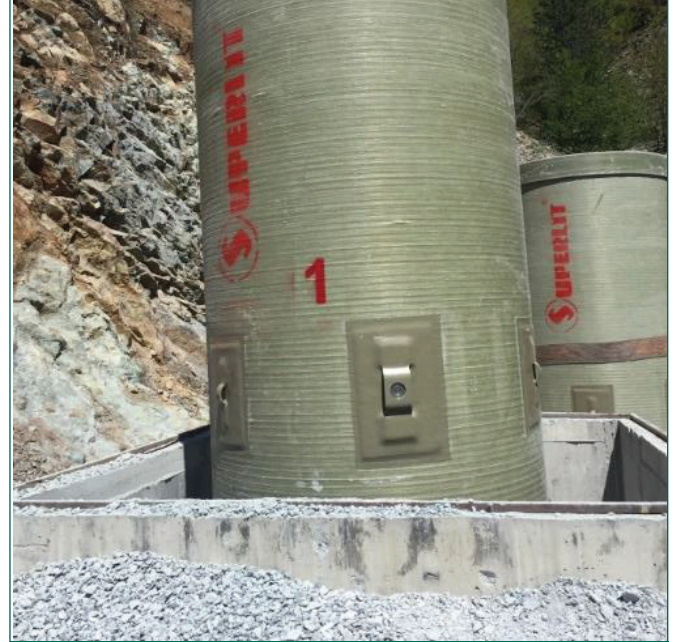
Fotoğraf 3. CTP Boruların Şaft İçerisine Montaj İşlemi
