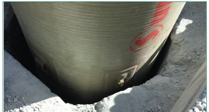
Fotoğraf 4. CTP Boruların Şaft İçerisine Montaj İşlemi
