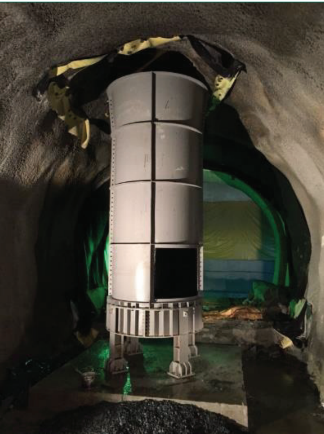
Fotoğraf 6. CTP Boru için Merkezleyici Çelik Kılıf
