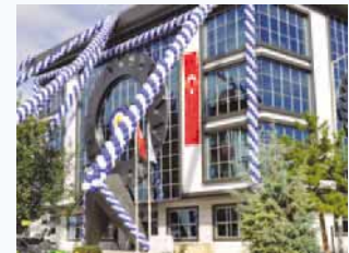
09 | Yeni Hizmet Binası Açılışı
